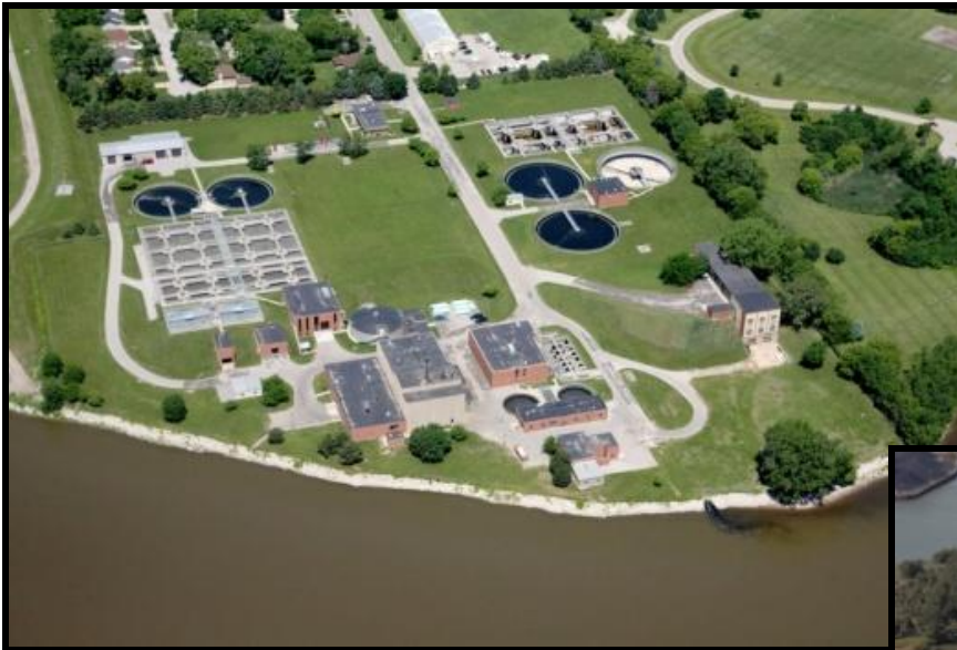
De Pere Facility
