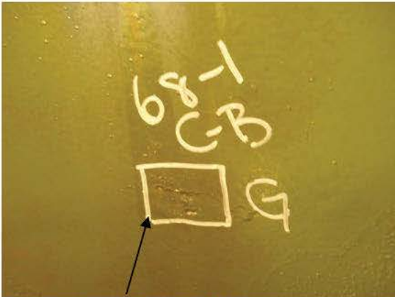
B-P68-1 GOUGE REPAIR
