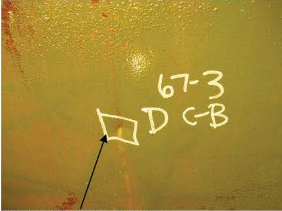
B-P67-3 GOUGE REPAIR
