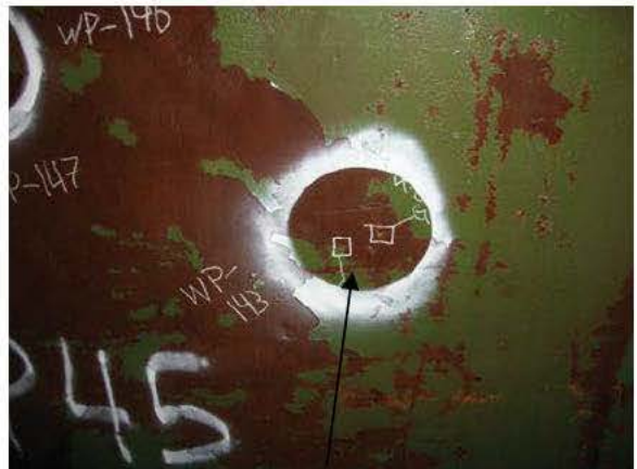
C-P45-5 GOUGE REPAIRS
