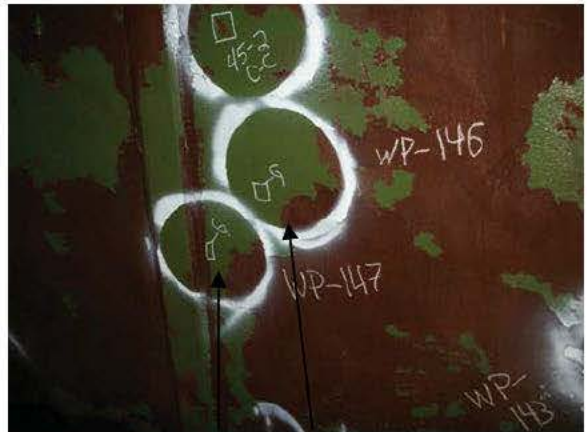
C-P45-4 GOUGE REPAIRS
