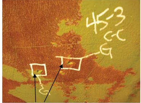
C-P45-3 GOUGE REPAIRS
