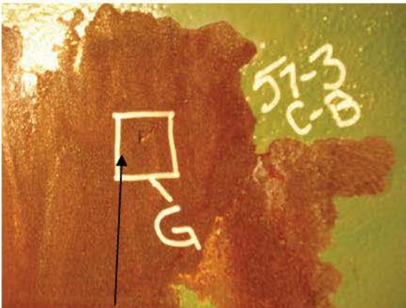
B-P57-3 GOUGE REPAIR
