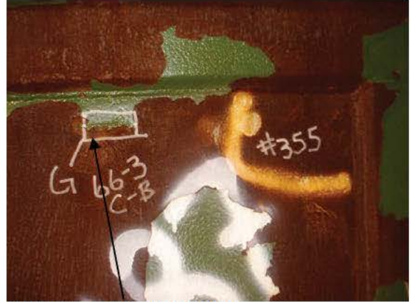
B-P66-3 GOUGE REPAIR
