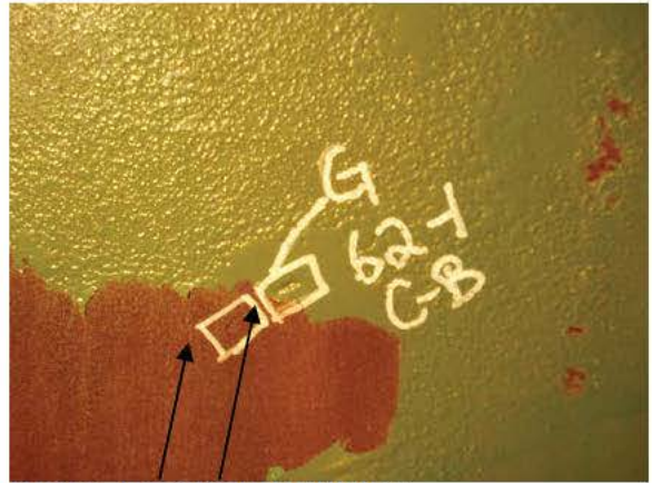
B-P62-1 GOUGE REPAIRS
