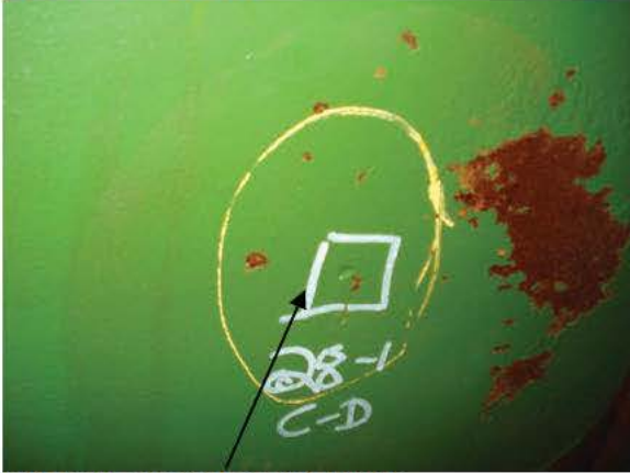
RD-P28-1 GOUGE REPAIR
