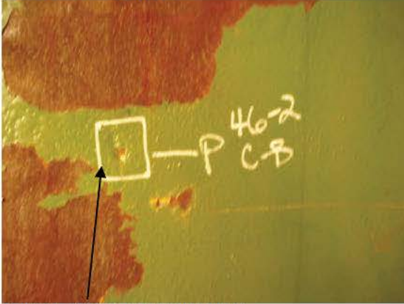
B-P46-2 GOUGE REPAIR
