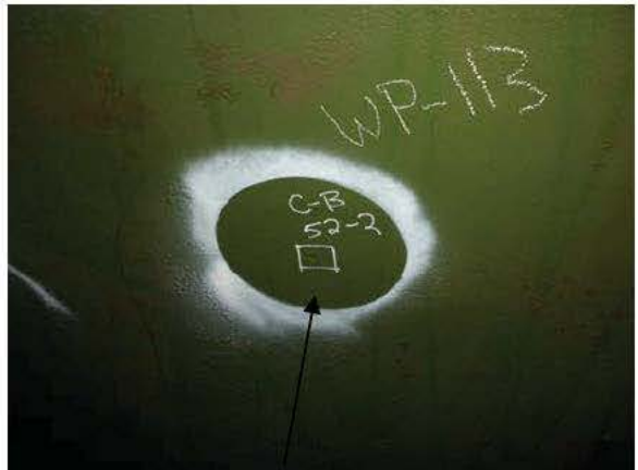
B-52-2 GOUGE REPAIR
