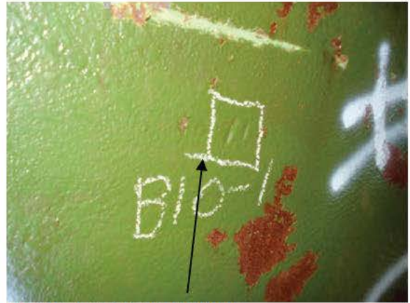
B-P10-1 GOUGE REPAIR
