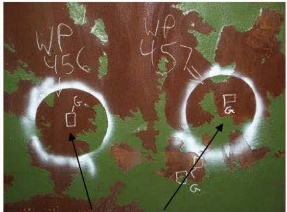
C-P25-1 GOUGE REPAIRS
