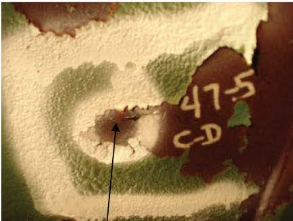
RD-P47-5 GOUGE REPAIR
