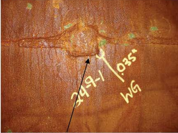
R24-P9-1 WELD GOUGE
