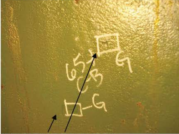
B-P65-1 GOUGE REPAIRS
