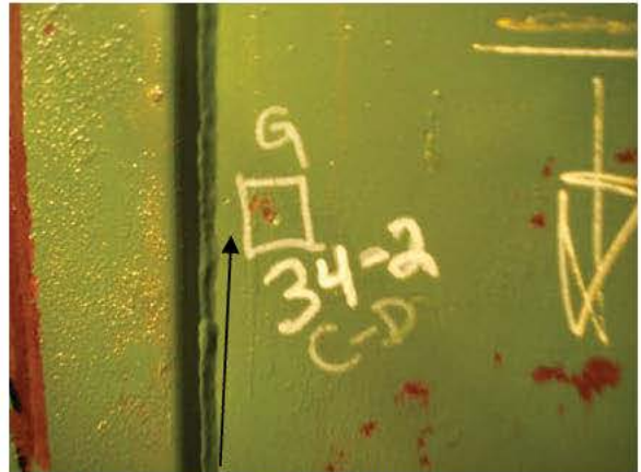
RD-P34-2 GOUGE REPAIR
