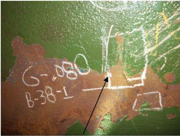
B-P38-1 GOUGE REPAIR
