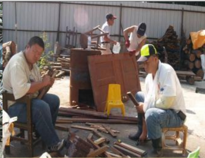
3. 修繕整理 Repairing
