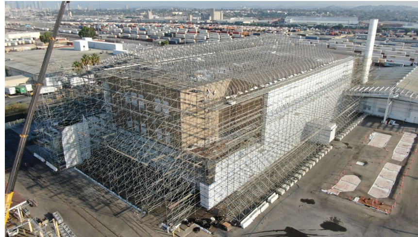
Segmento 3 Instalación de armadura de techo FEU
