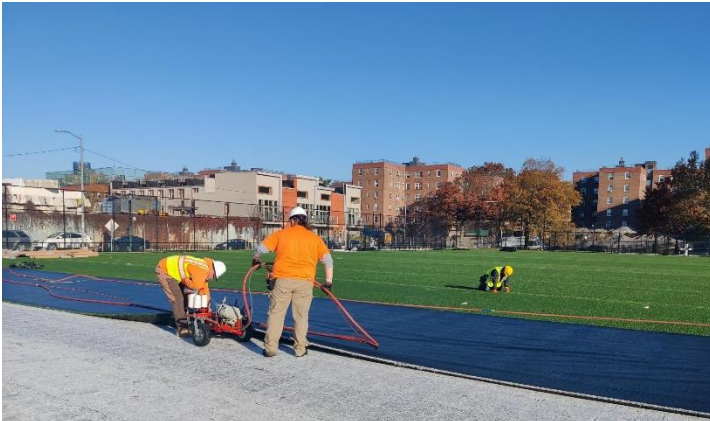
Contratistas instalando césped artificial en los campos 5 a 8
