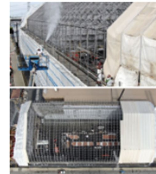
Eliminando la Unidad de Recinto Completo de Segmento 2 del Edificio de Fundación.
