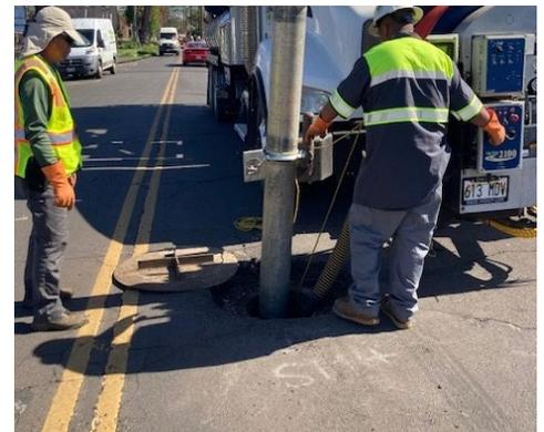
*Figura 2. Contratistas de la EPA inyectan agua en una tubería de alcantarillado para eliminar residuos y obstrucciones.*
