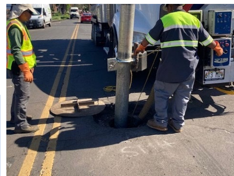
Figure 2. Ang mga contractor ng EPA ay naglalagay ng tubig papasok sa sewer pipe upang maalis ang anumang mga dumi/harang.
