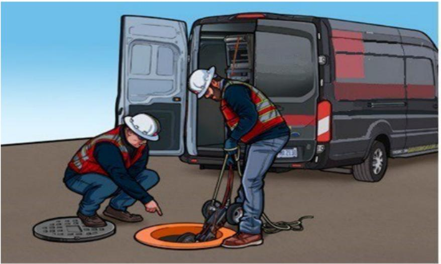
**Destapando las líneas de alcantarillado:** El primer equipo usara una aspiradora y lavadora de agua para destapar las líneas. Este trabajo incluye pasando agua a alta velocidad entre dos pozos de inspección para destapar la línea de escombros y recolectando con una aspiradora a un tanque seguro. Si está cerca, podría ser ruidoso.
