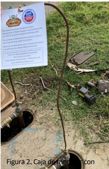
Figura 2. Caja de medidor con aparato y letrero informativo.
