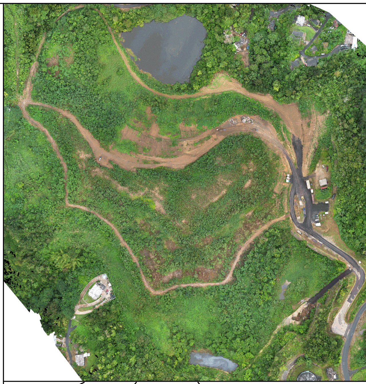
FOTO AÉREA (DRONE) N.T.S.
